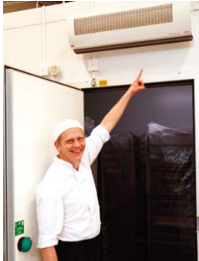
-Inget kallras längre, förklarar produktionschef Johan Landerhjelm vid Stigs Café & Bageri. Aggregatet skapar en luftfridå. Ingen kyla lämnar frysummet utan luften trycks ned, när dörren öppnas. Det är mycket bra för när det blir mycket spring kan det vara svårt att hålla rätt temperatur både i bageriet och frysen.
